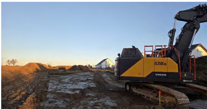
Baggerarbeiten für den Bau der Tiefgarage
