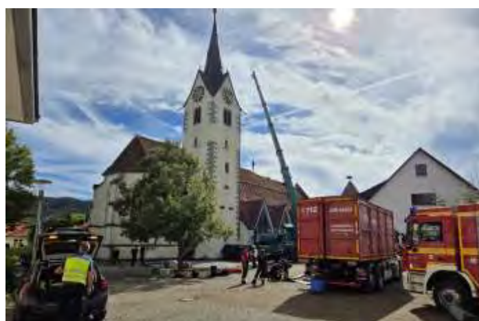
Dachabdichtung an der Bohlinger Pfarrkirche
