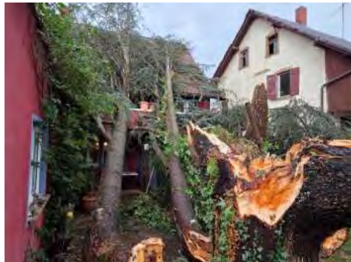
Umgestürzter Baum auf Wohnhaus Zum Gaißenbühl
