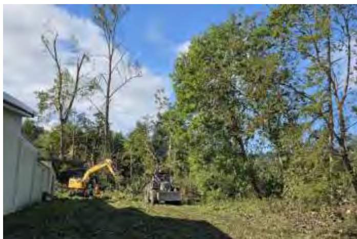
Komplett umgefallene Waldfläche am Schützenhaus
