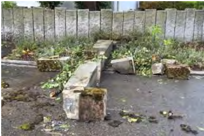
Umgefallenes und zerstörtes Feldkreuz Zum Stationenweg
