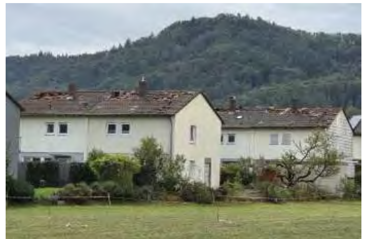
Reihenweise abgedeckte Häuser in der Schienerbergstraße
