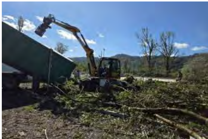
Aufräumen mit Großgerät am Sportplatz und beim Reitverein
