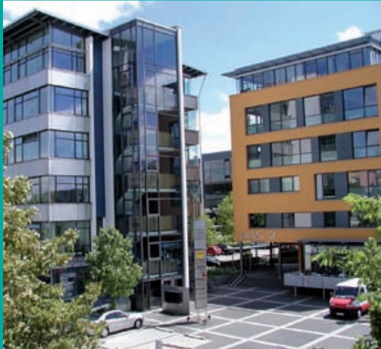
Eingangsbereich DAS! 1 und DAS! 2
