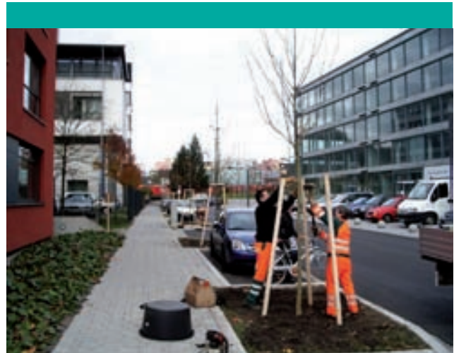
Neugestaltung Maggistraße kurz vor der Fertigstellung 2009
