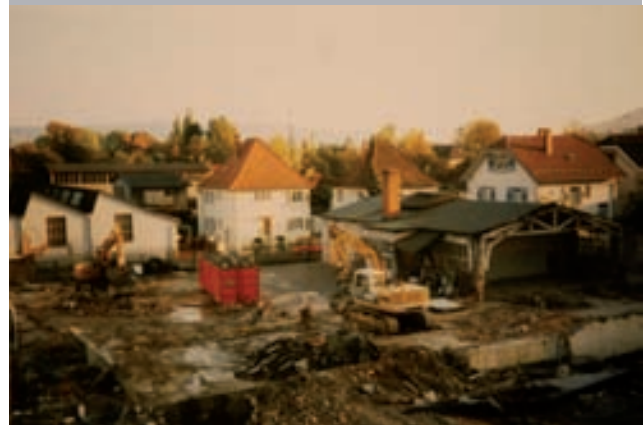
Abbruch Wehrdstr. 3a
