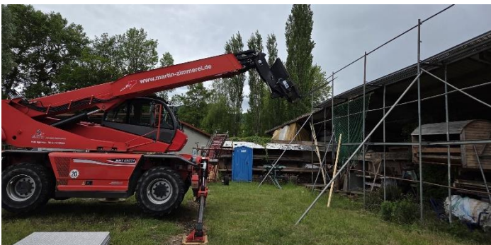
Kran zum aufbringen des neuen Daches
