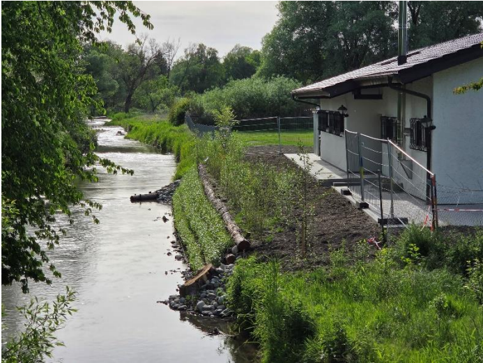
Neue Aachböschung am Clubheim des SV Bohlingen
