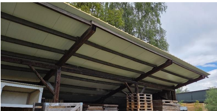
Neues Dach im Mattesareal
