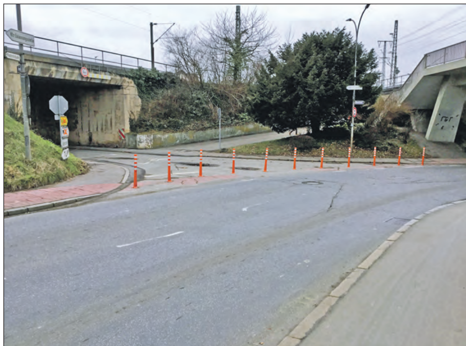
Für die Sicherheit von Radfahrerinnen und Radfahrern: Die Fittingstraße wird dauerhaft zur Sackgasse, die Durchfahrt auf die Güterstraße bleibt für den motorisierten Verkehr gesperrt.
