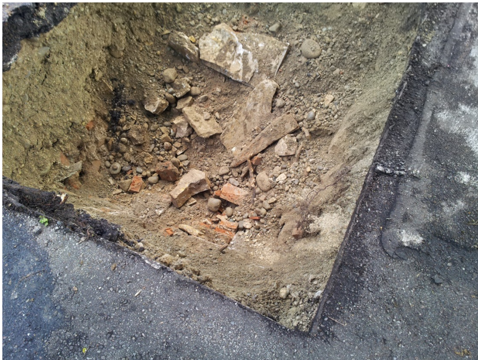
Bild 5. Schurf Nr. SCH2(II), aufgefülltes Keller
