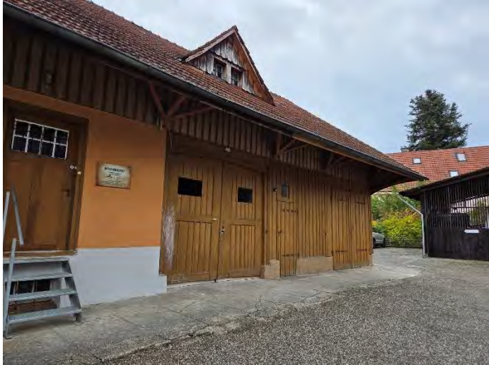
Scheune in welcher der Hofladen entsteht
