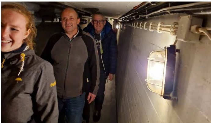
Im Bundesbankbunker in Cochem
