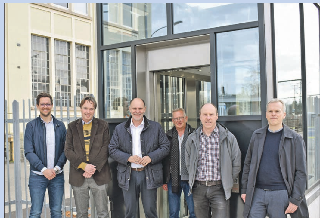
Bei der offiziellen Inbetriebnahme des Aufzugs Maggi-Tunnel in der Julius-Bührer-Straße (von links): Ingenieur Lucas Burger, Maggi-Werksleiter Pascal Moser, OB Bernd Häusler, Ekkehard Sigg und Michael Spreitzer (Straßenbau) sowie Thomas Mügge, Fachbereichsleiter Bauen.
