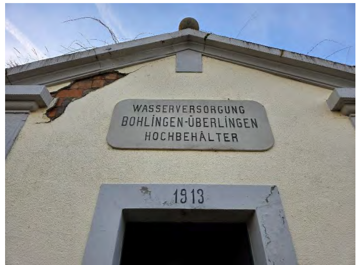
Sichtbare Gebäudeschäden am alten Wasserhochbehälter
