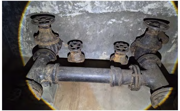
Alte Schiebereglер im Wasserhochbehälter
