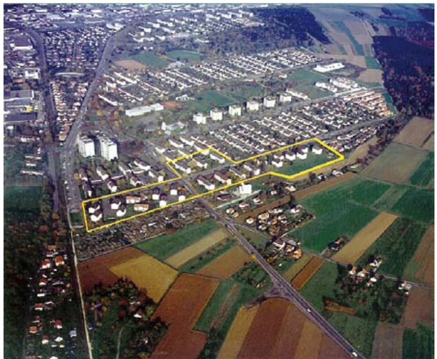
Abbildung 2.1-1: Das Sanierungsgebiet „Langenrain“ 6 in Singen vor dem Beginn der Sanierung
