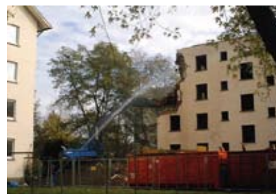
Abbildung 10.3-7: „Etwa 4-6 Wochen dauerte ein Abbruch, bei dem sorgfältig vom Dach bis in den Keller abgebrochen, Material getrennt, Mauerwerk und Beton gebrochen und entsorgt wurde.“ 11
