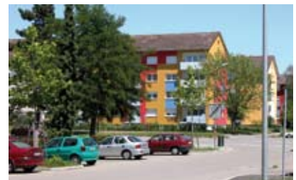
Abbildung 10.4-4: Blickrichtung von Langenrain-West in Berliner Straße und Langenrain-Ost
