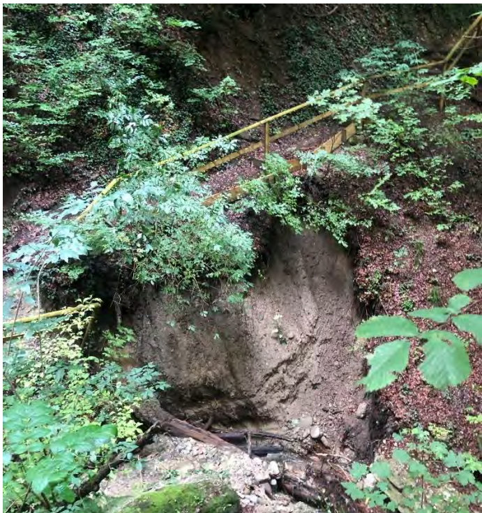
Unter der Humusschicht kommt der Sandstein zum Vorschein
