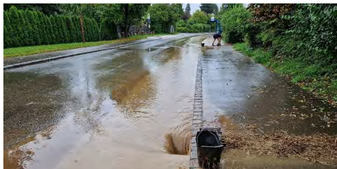
Durch das Ziehen der Gullideckel und leeren der Körbe konnte schlimmeres verhindert werden.
