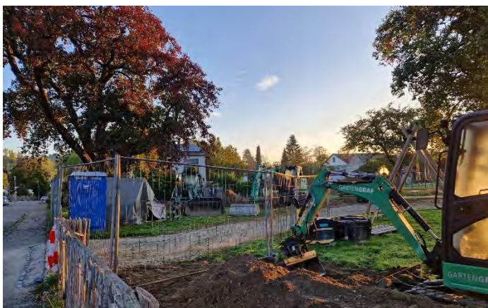
Bauarbeiten auf dem Spielplatz Kellerbreiten
