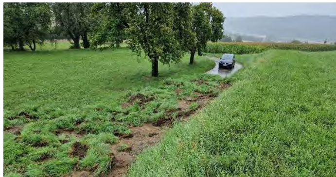
Böschungsrutschung auf 150 Meter Länge auf der Straße Zum Haslen
