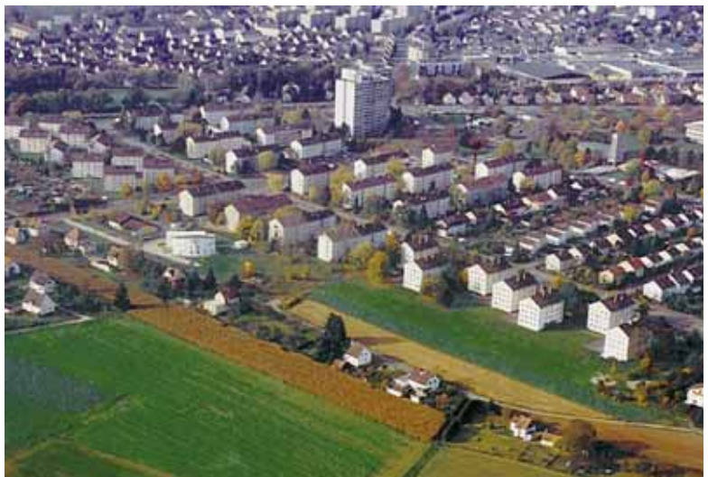
Vor Beginn der Sanierung
