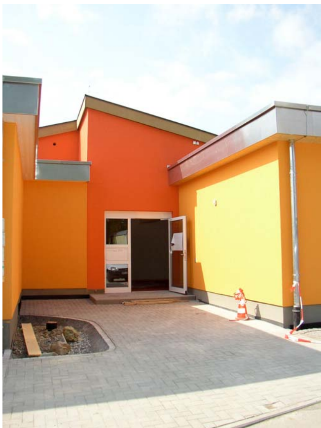
Der neue Eingangsbereich des Kindergartens
