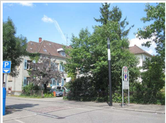
Blick von der Kreuzung Thurgauer Straße/ Bahnhofstraße in den Hof des ehemaligen Zollgebäudes
