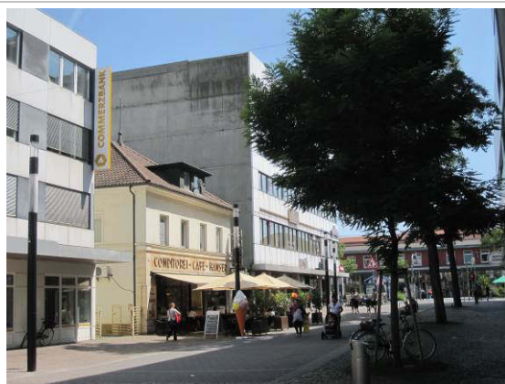
Blick von der August-Ruf-Straße auf das abzubrechende Handelszentrum und das Café Hanser (bleibt erhalten)
