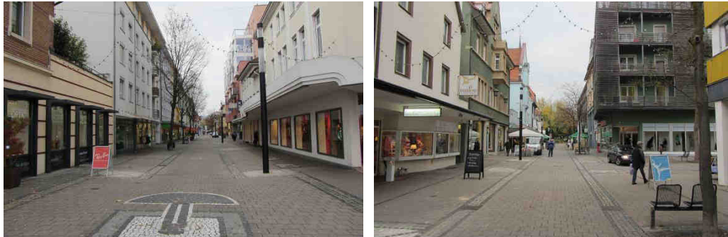
Abbildung 6: Südlicher (links) und nördlicher Bereich (rechts) der Scheffelstraße
