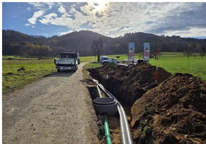
Abwasserschächte und Zuleitungen für Strom
