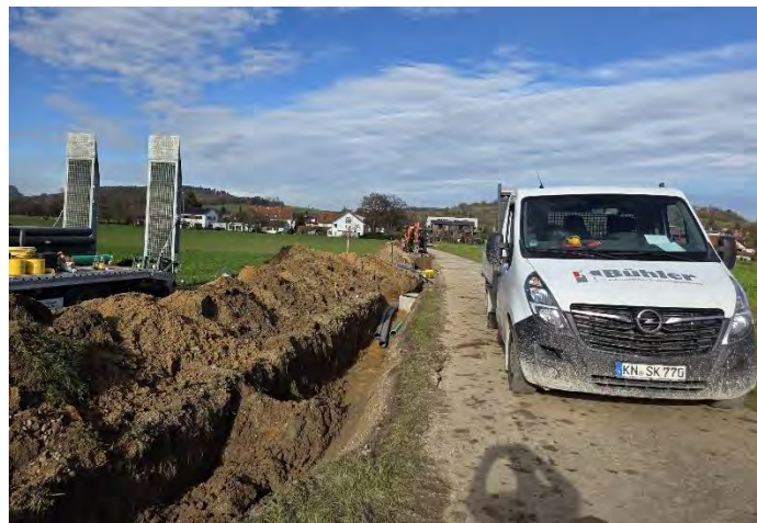
Gräben für die Versorgungsleitungen
